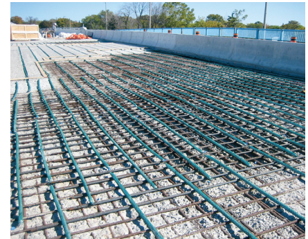
Galvashield® DAS Tipo F Sistema de ánodo distribuido en losa de puente antes de vaciar el concreto.
