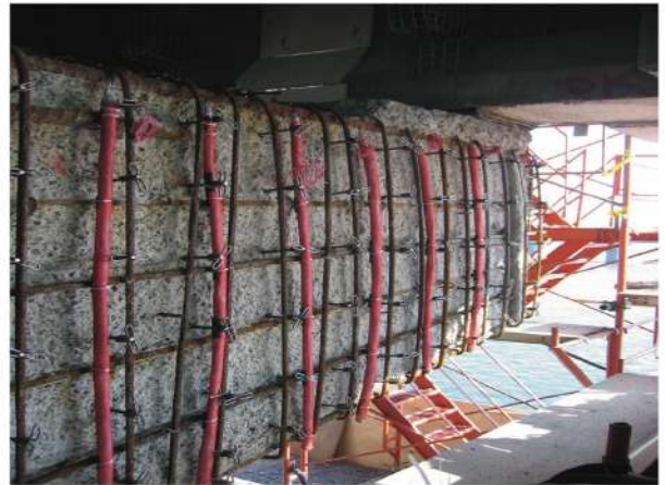
Sistema Galvánico de ánodos en pórtico antes del colado del nuevo concreto
